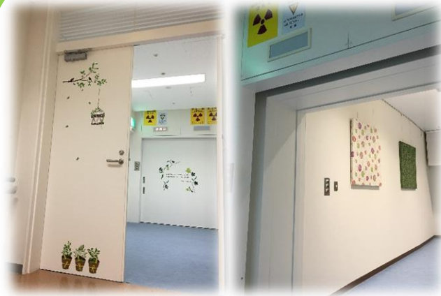
照射室へと続く廊下
